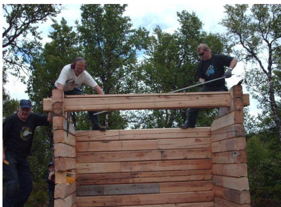
Konstruksjonen tar form under kyndig ledelse.
